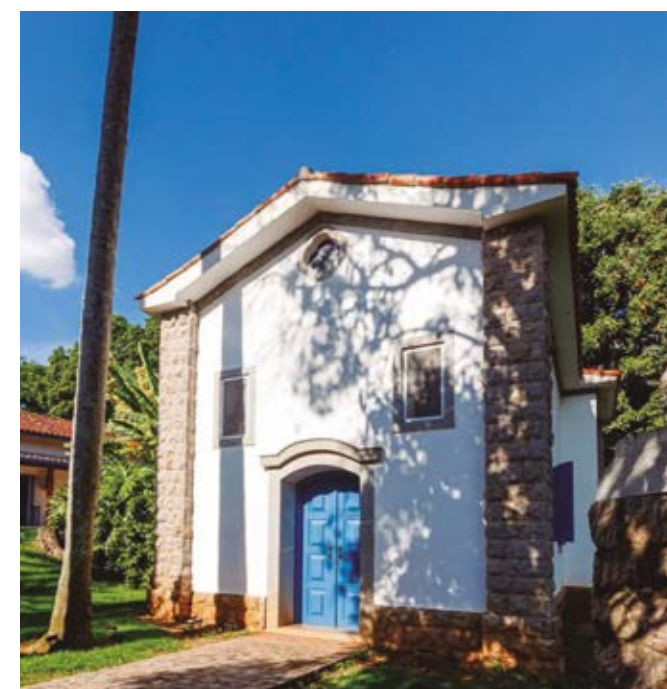
Cercada por uma vasta área verde, abriga biblioteca, piscinas e capela
